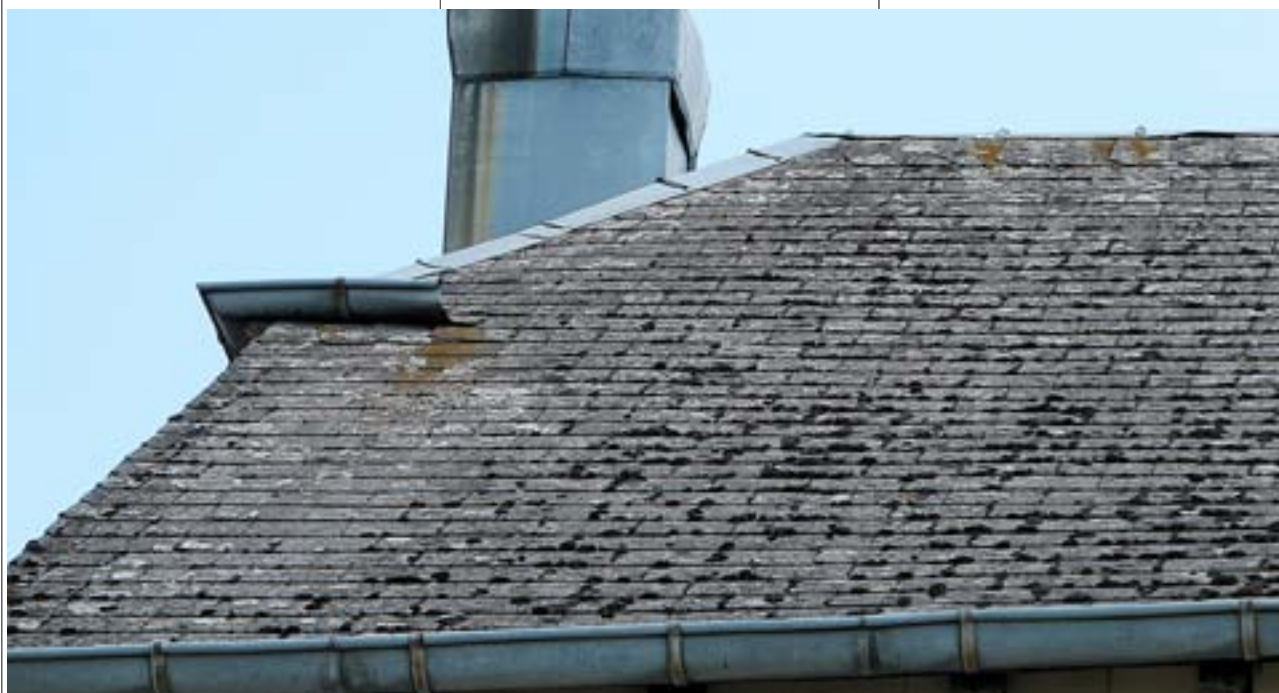
Telhas do telhado com amianto-cimento
