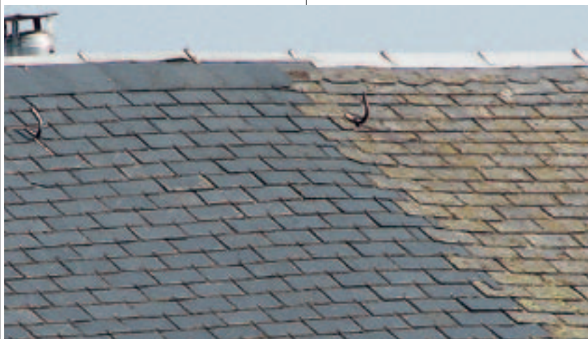
Esquerda: telhas sem amianto-cimento - Direita: telhas com amianto-cimento
