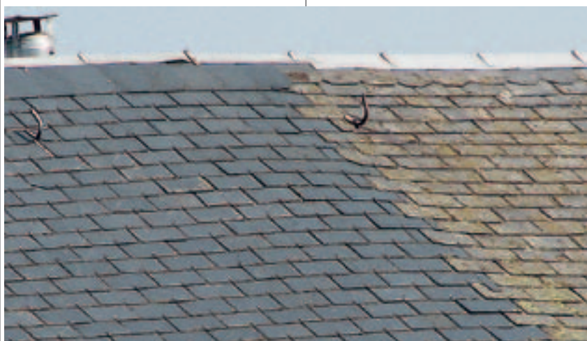
A gauche: plaques sans amiante-ciment – A droite: plaques avec amiante-ciment
