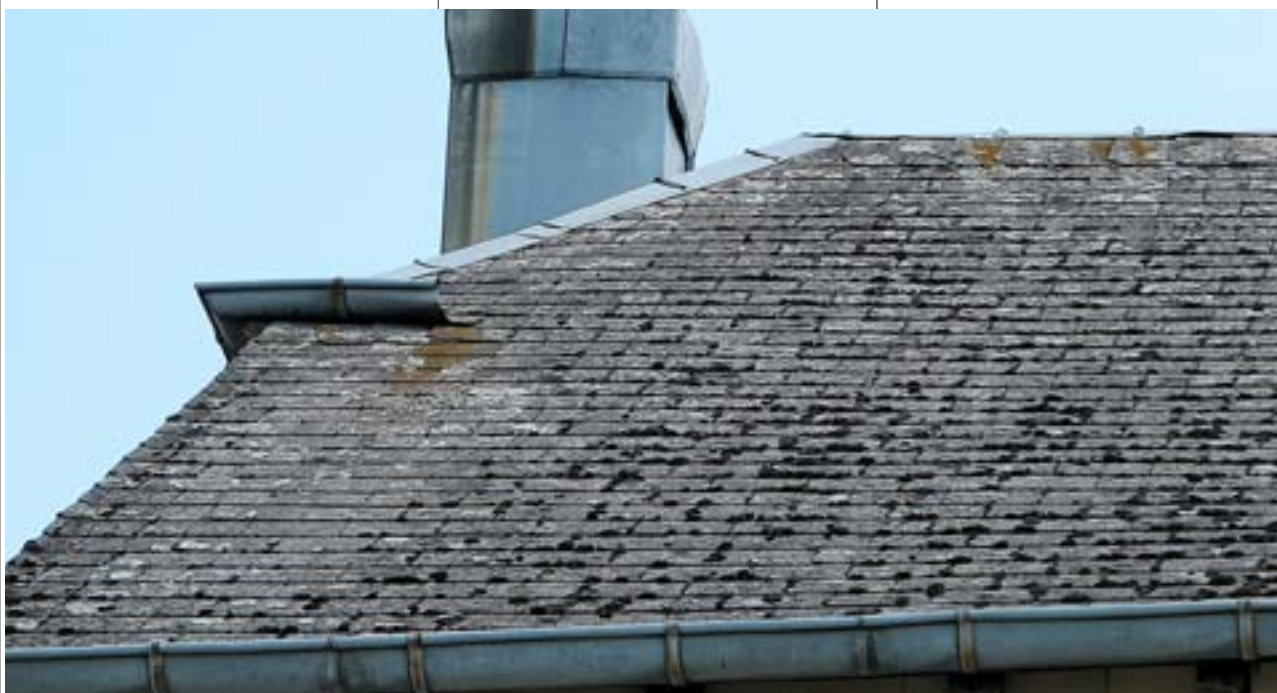
Toiture avec plaques en amiante-ciment
