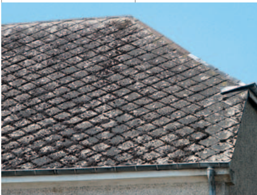
Toiture avec plaques en amiante-ciment
